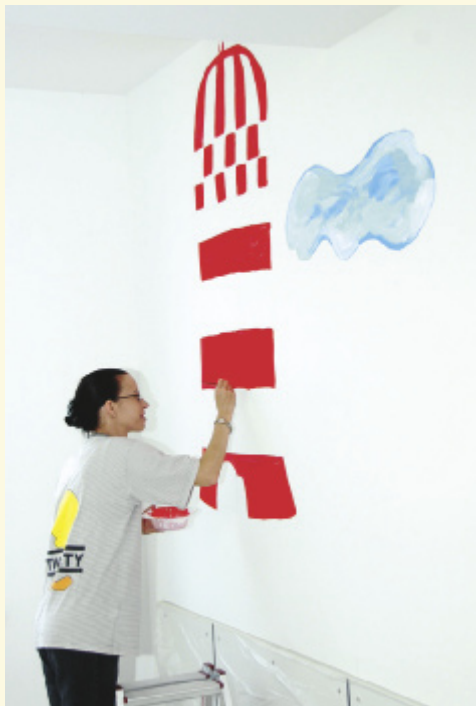
Ärzte, Schwestern und Erzieherinnen zeigten viel Talent beim Bemalen der Wände auf der neuen Station (Fotos: Elke Lindner)
